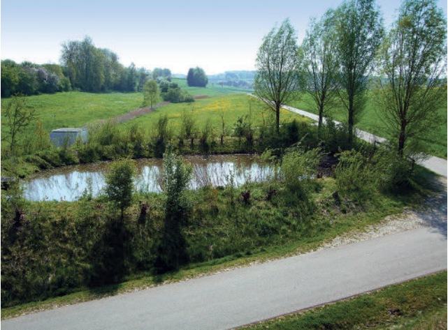
Bild 2: Ein künstlich angelegter Teich, der durch einen kleinen Bach ständig mit Wasser versorgt wird und über Fahrwege erreichbar ist, stellt eine ideale Löschwasserversorgung am Ortsrand dar. Zur Verwendung mit Hubschrauber und Außenlastbehälter muss die Bepflanzung angepasst werden, um keine Gefahr bei An- und Abflug darzustellen.
