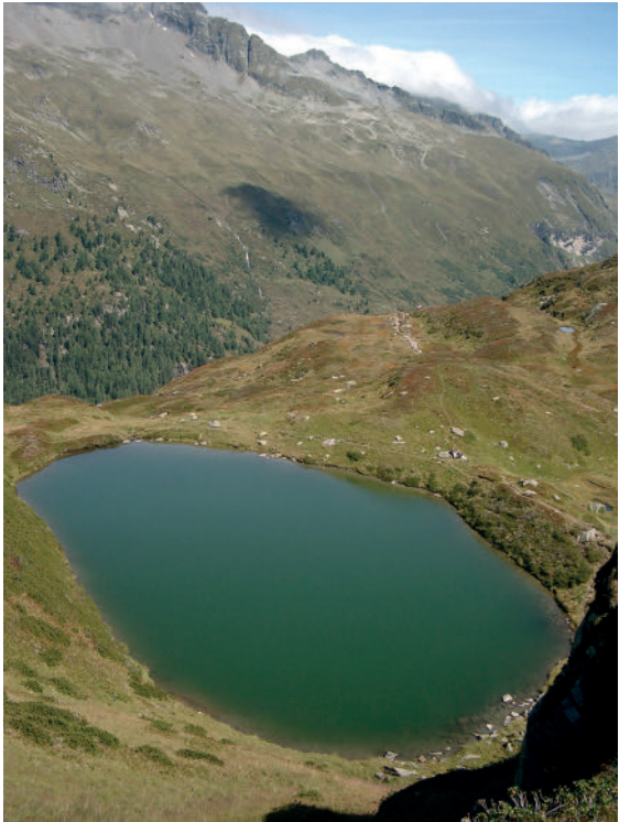
Bild 3: Ein künstlich angelegter See im Gebirge als Reservoir für eine Beschneigungsanlage ist als Löschwasserteich auch für Hubschrauber mit Außenlastbehälter geeignet.
